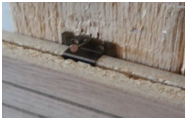
Uchytení desky ocelovým klipem
