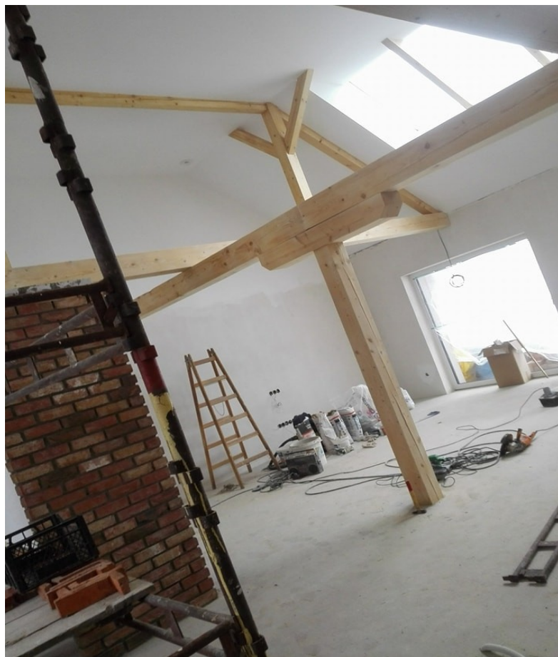
Nosná konstrukce krovu
