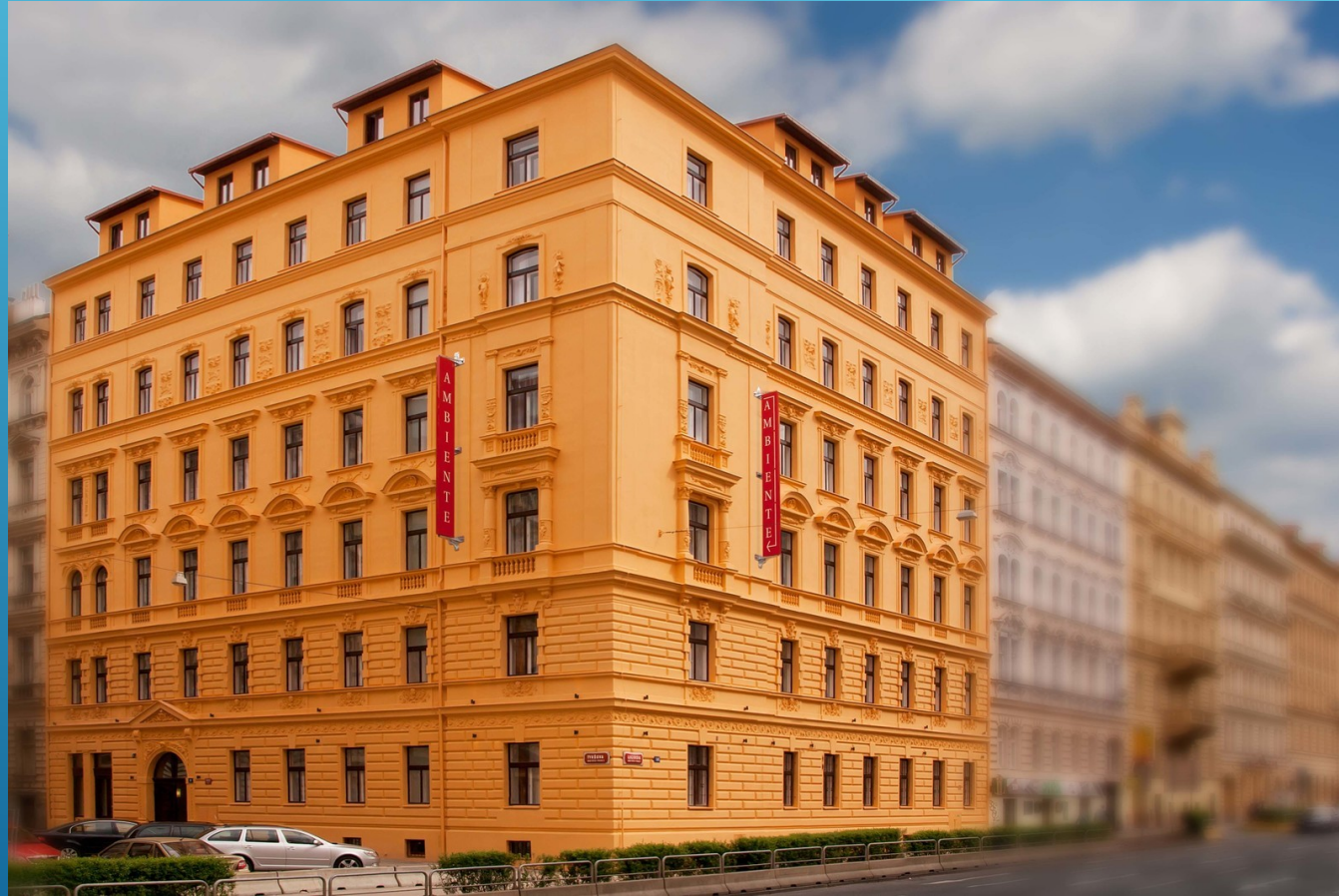
Pohled na sanovaný objekt Zdroj: www.ambiancehotel.cz .
