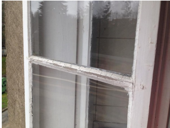
Rekonstrukce špaletových oken
