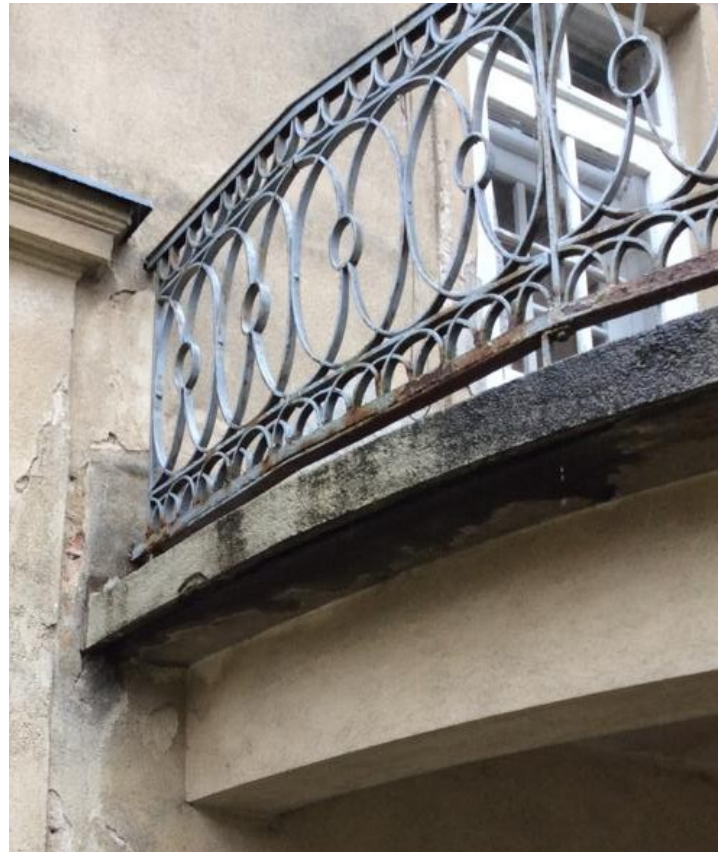
Rekonstrukce balkónu a zábradlí
