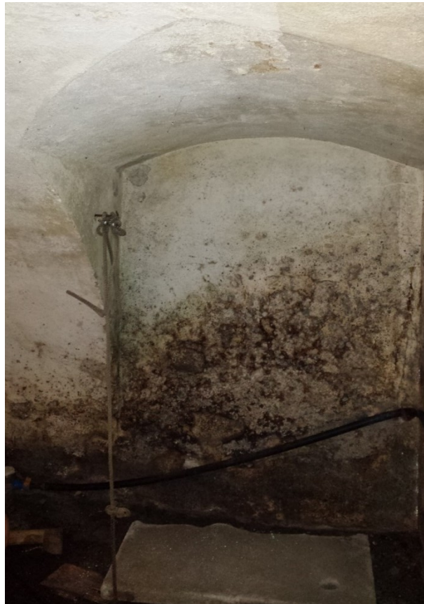
Rekonstrukce spodní stavby
