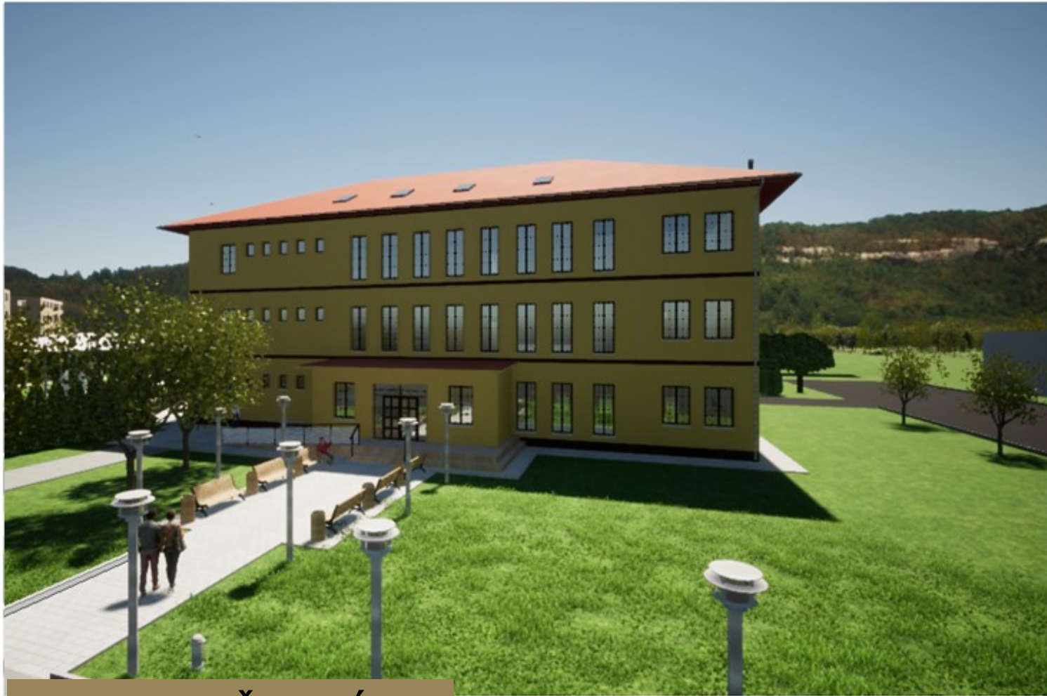
VSTUP A ČELNÍ STĚNA
