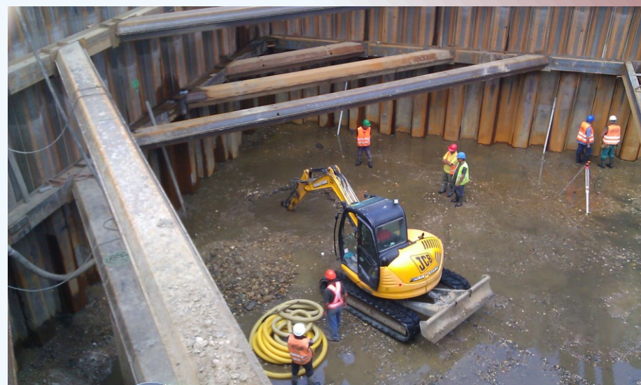
REALIZACE PRŮZKUMNÉ SONDY PRO UMÍSTĚNÍ ČERPACÍ STUDNY (zdroj: Vlastní tvorba)
