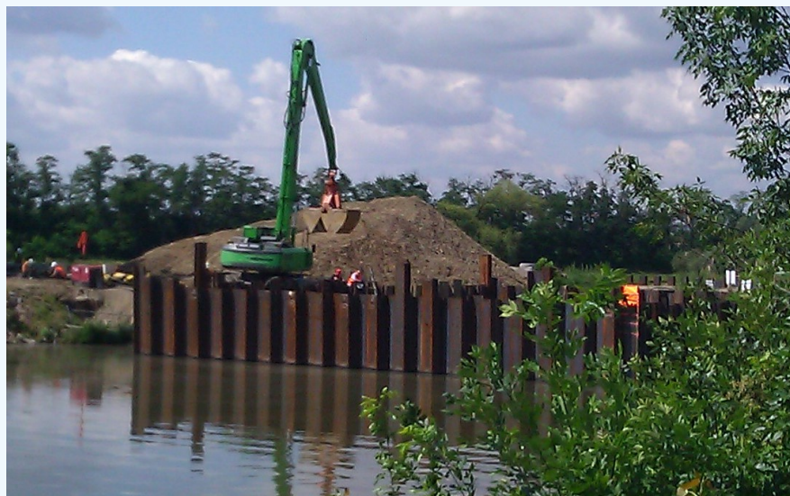
ZAHÁJENÍ TĚŽBY POD ÚROVNÍ HLADINY TOKU (zdroj: Vlastní tvorba)
