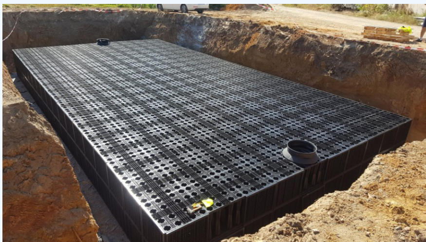
UKÁZKA REALIZACE VSAKOVACÍCH BLOKŮ (zdroj: internet)
