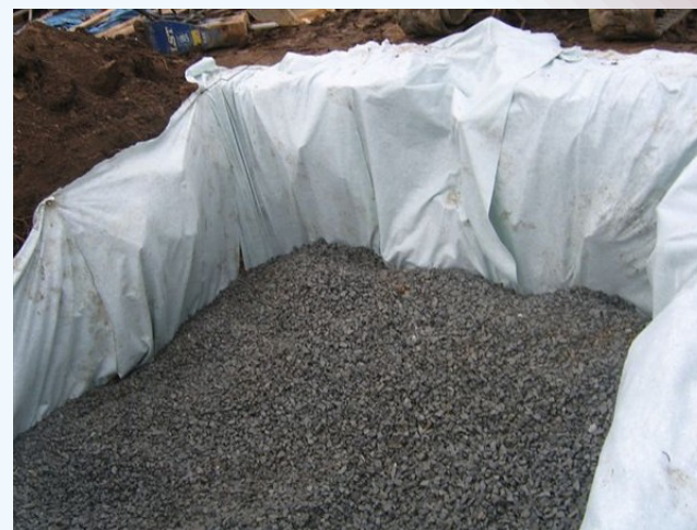
UKÁZKA REALIZACE ŠTĚRKOVÉ VSAKOVACÍ JÍMKY (zdroj: internet)
