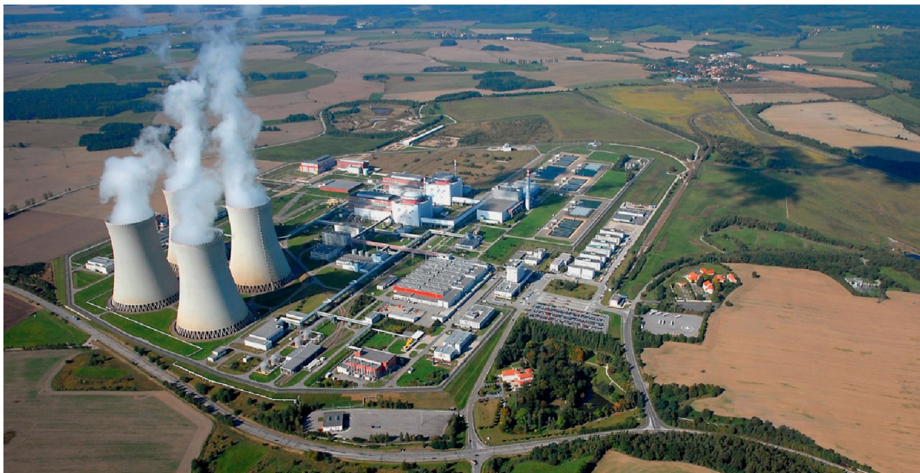
Jaderná elektrárna Temelín
