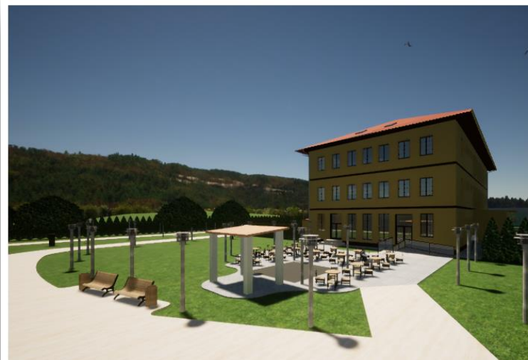
TERASA A SZ STĚNA
