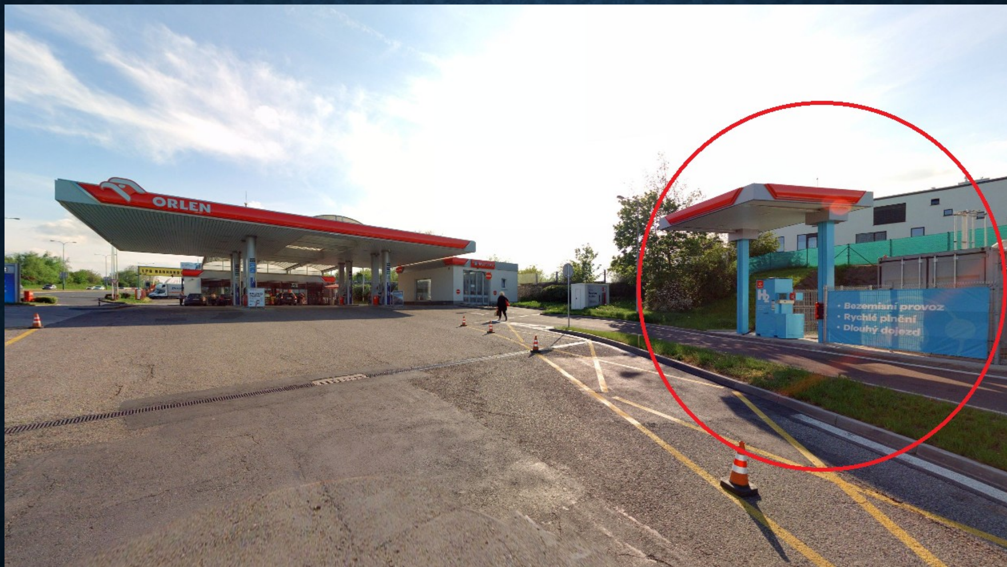
Obrázek 3: Implementace vodíkové čerpací stanice, (K Barrandovu 1136/6, 15200 Praha 5 - Hlubočepy)
