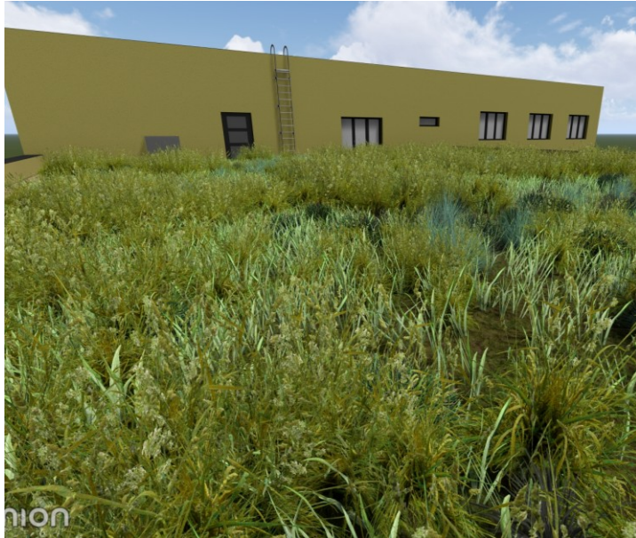
Extenzivní vegetační střecha
