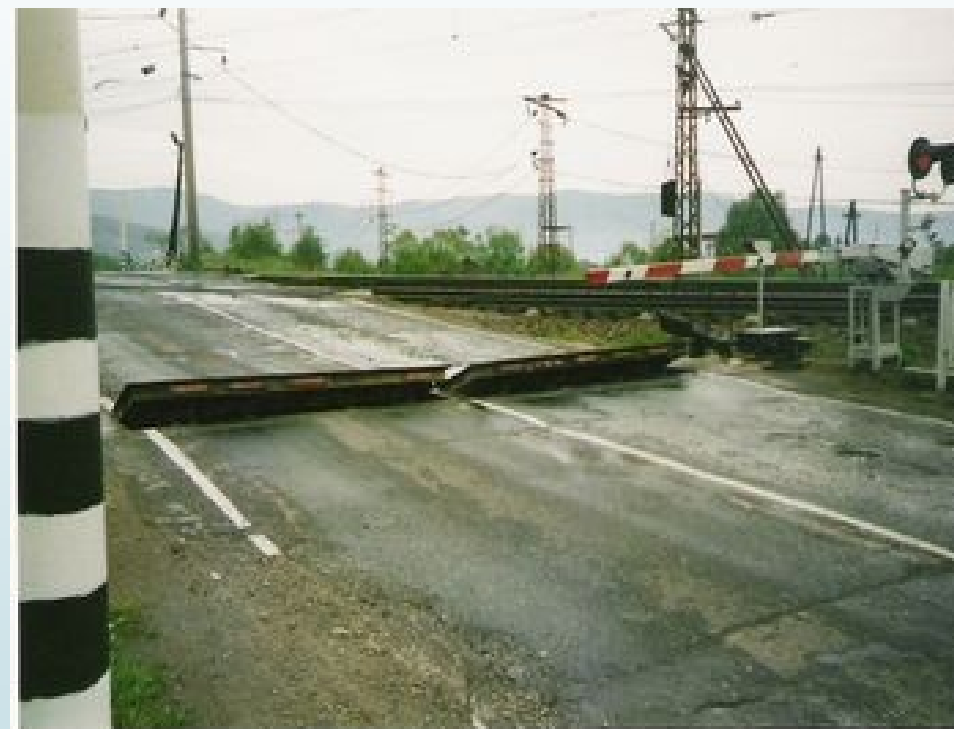
Obr. 4 - Zdvihací zábrana na železničním přejezdu
