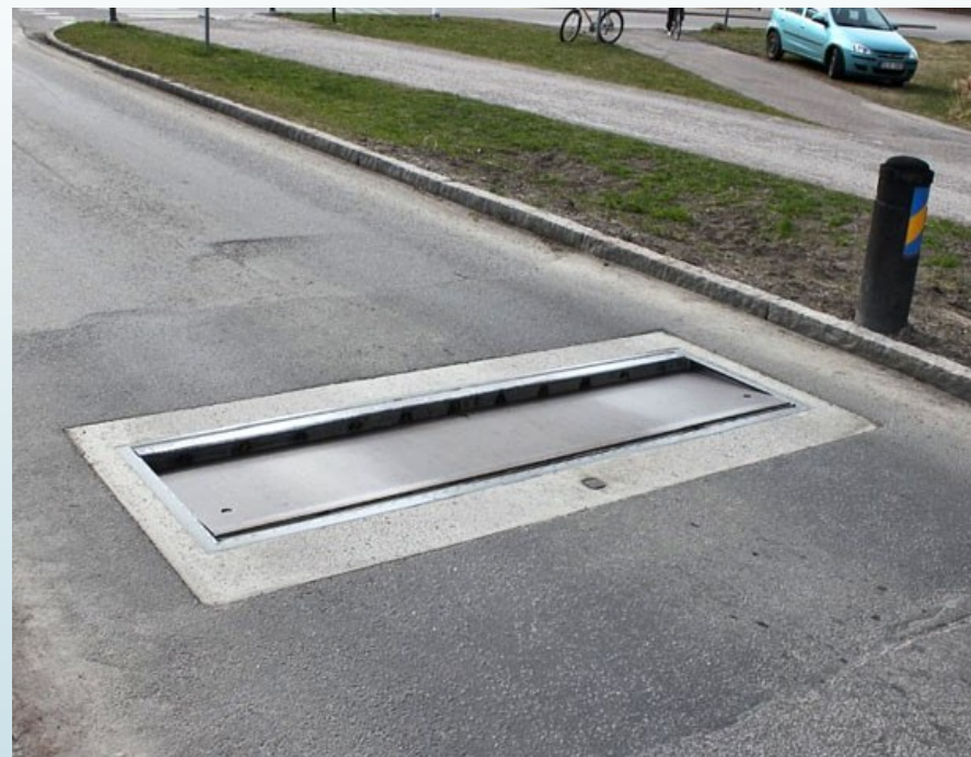
Obr. 2 – Aktivní příčný práh
