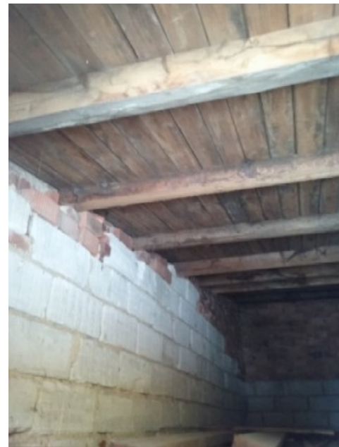
Obr. č. 12 nosné trámy
