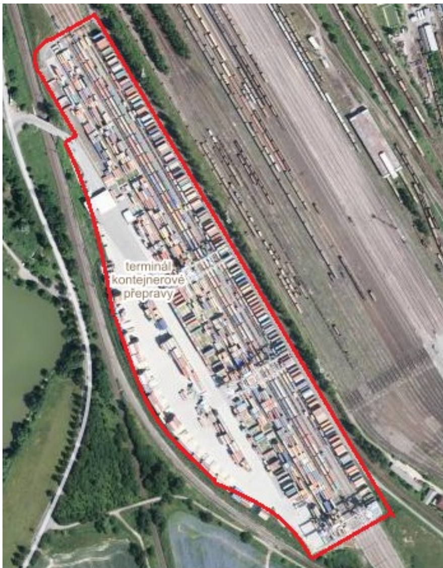
Terminál kombinované dopravy Metrans, a.s., Česká Třebová
