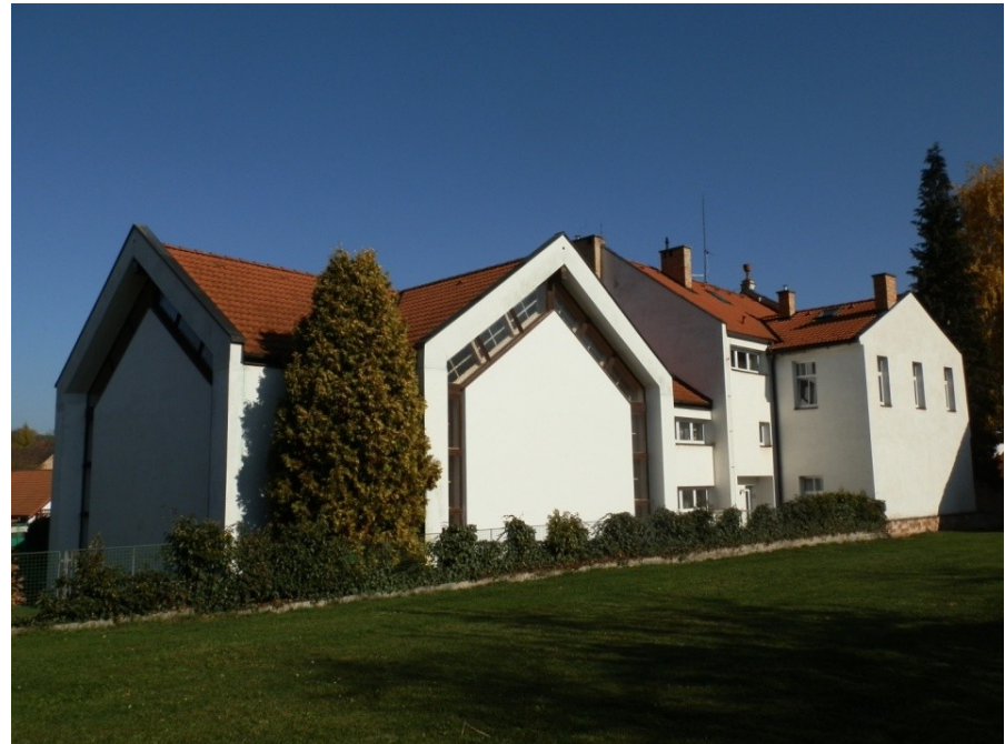
Současná modlitebna navazující na původní budovu
