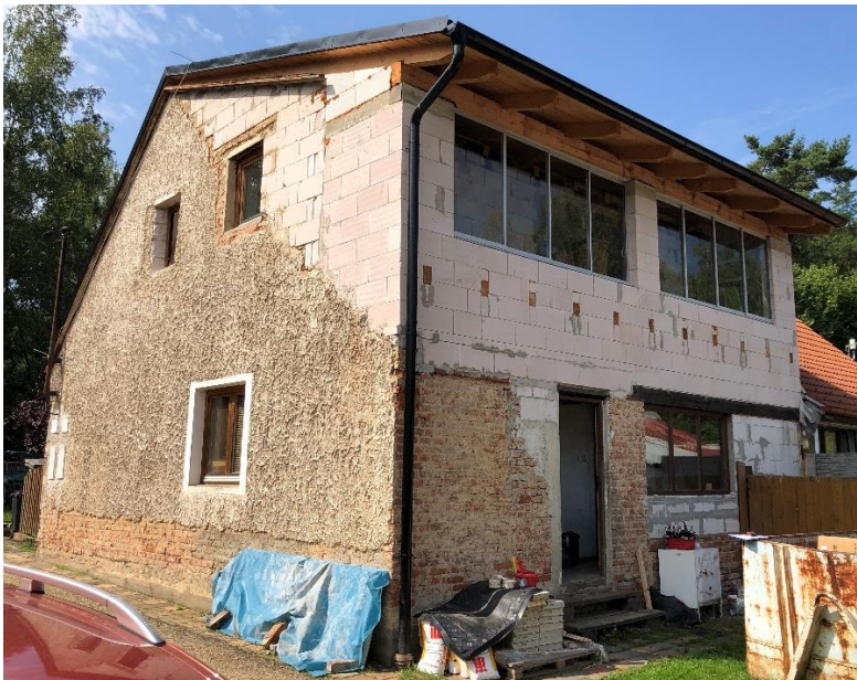
Obrázek 6: Fotografie řešeného objektu
