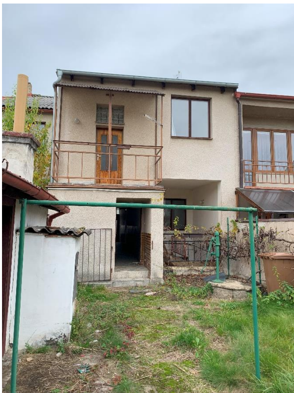
Obrázek 3: Zaměřovaný objekt řadového domu – pohled ze zahrady
