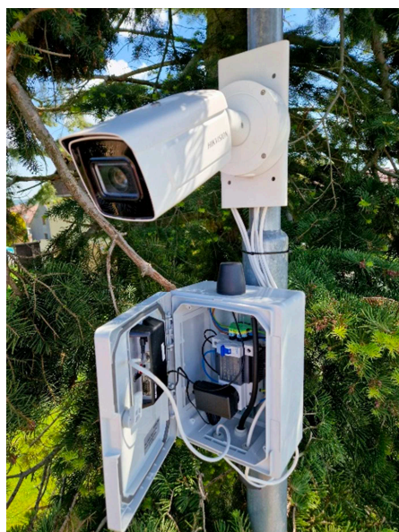
Obr. 3 | Ukázka instalace kamery včetně komunikačního rozhraní a elektr. vybavení
