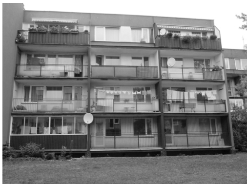
Obr. 78 Individuální úpravy balkonů panelového domu (foto: Helena Míková Hexnerová)
