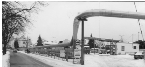
Obr. 19 Chrudim – nábřeží Chrudimky destruované infrastrukturou (foto: Ivan Kaplan)
