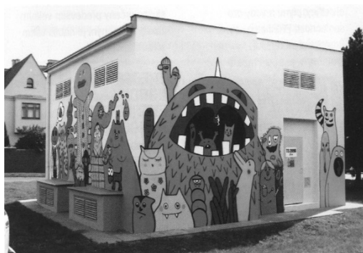
Obr. 21 Březno u Chomutova – trafostanice v obnoveném parku (foto: Ivan Kaplan)
