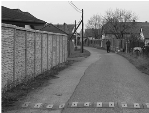
Obr. 90 Ukázka degradace uličního prostoru nevhodným oplocením (foto: František Pospíšil)
