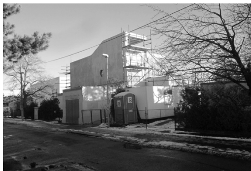
Obr. 79 Zateplování funkcionalistické vily fasádními polystyrenovými deskami (foto: Helena Míková Hexnerová)
