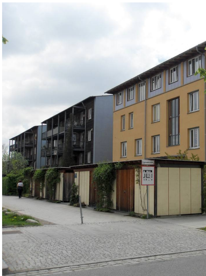
Malé sklady jsou součástí vnitřní pěší ulice a nahrazují garáž, sklad i dílnu, která bývá typickou součástí rodinného domu. Činnosti zde vykonávané oživují dění v ulici: OS u Olympiapark, Mnichov
