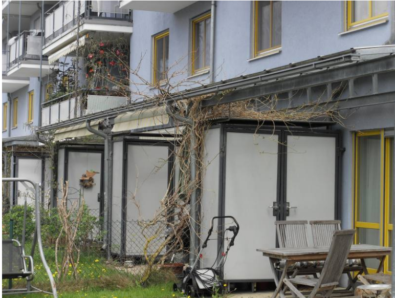
Jednotlivé zahrádky přístupné z přízemních bytů jsou vizuálně odděleny umístěním úložných skříní: OS u Riem Park, Mnichov
