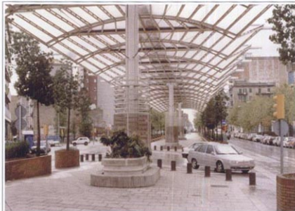
Španělsko - BARCELONA obslužná komunikace se zastřešenou pěší promenádou /arch. Santiago Calatrava/
