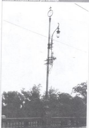
Praha – Most leglí u Národního divadla Speciální osvětlovací stožáry sloužící zároveň jako stožáry nesoucí trolejové vedení pro tramvaje.
