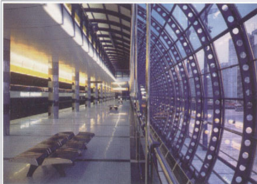
PRAHA povrchová stanice metra Rajská zahrada na trase B
