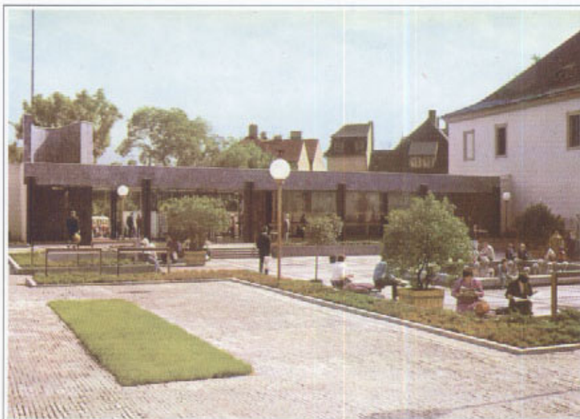
PRAHA povrchový vestibul stanice Malostranská na trase A
