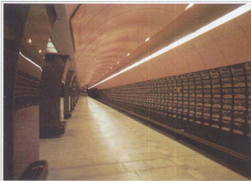
PRAHA stanice Náměstí Republiky na trase B metra
