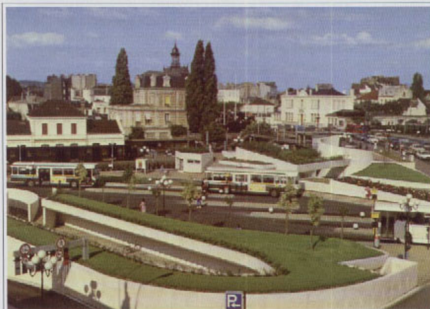
Francie - předměstí PARIŽE čtvrť MAISSONS LAFFITE menší autobusové nádraží
