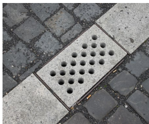
352 Možný příklad prvku odvodnění ulice z materiálu, shodného s navazujícím povrchem [ Frýdlant ]
