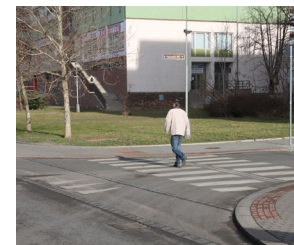
110 Zvýšená vozovka na vjezdu do zklidněné zóny 30 s přechodem pro chodce v úrovni chodníku [ Praha 10, Moskevská ]
