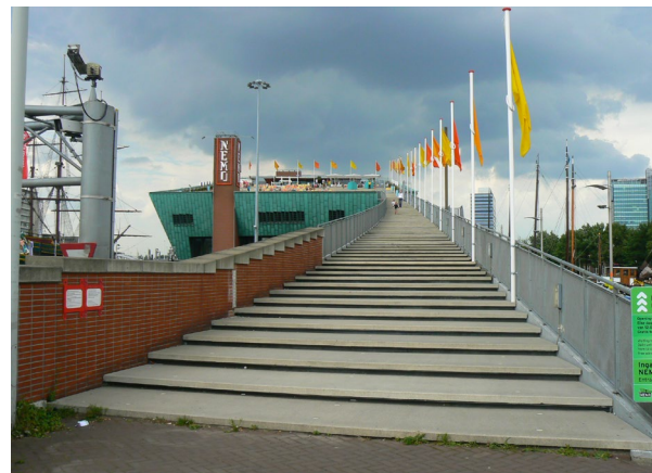
038 Pobytová střecha muzea je veřejně a snadno přístupná přímo z nábřeží. Renzo Piano (1997) [ Nizozemí, Amsterdam, Science Center Nemo museum ]
