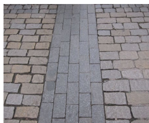
211 Hladký pruh pohodlnější pro cyklisty a pěší, vhodný i pro orientaci v prostoru. Vhodná aplikace v historickém městě [ Praha 1, Staroměstské náměstí ]
