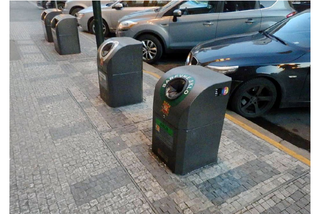
443 Kvalitní podzemní kontejner s průběžnou dlažbou [ Praha 1, Platněšská ]
