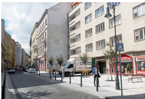
014 Častým pražským jevem jsou místa funkcionalistických činžovních domů, kde stavební čára odstupuje od uliční. Vzniká tak příležitost k obohacení ulice o drobné pobytové prostranství [ Praha 1, Soukenická ]
