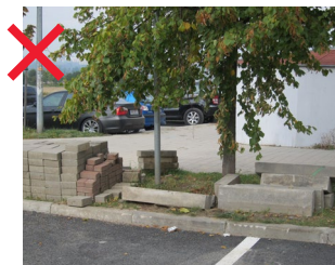
324 Nepřípustná, ale běžná praxe. Skladování materiálu v ochranné zóně stromu [ Praha ]
