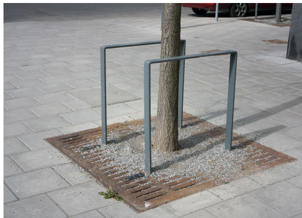
428 Esteticky kvalitní řešení stojanů, které zároveň plní funkci ochrany stromu [ Švédsko, Stockholm ]
