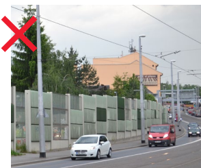
532 Protihlukové stěny užívané na městských komunikacích, které mají potenciál být městskou ulicí je zásadně nevhodné [ Praha 5, Radlická ]
