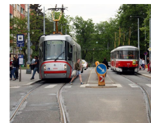
123 Zátková zastávka s dělicím ostrůvkem ve středu sružená pro tramvaje a trolejbusy [ Brno, Klusáčkova ]
