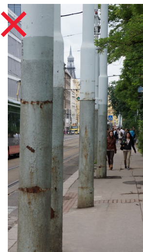
370 Nekoncepční umístování sloupů trakčního tramvajového vedení do prostoru chodníku pouze dle požadavků na statiku vytváří bariéry pro pohyb po chodníku a degraduje celkové vnímání prostoru náměstí [ Praha 2, Karlovo náměstí ]
