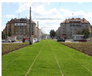
234 Tramvajový pás po zatravnění. Tento druh zatravnění vyžaduje vysoké nároky na údržbu v podobě zavlažování a sečení [ Praha 6, Podbaba ]
