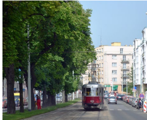
371 Trakční vedení v podobě sloupů s výložníky, které jsou umístěny v ose stromořadí [ Praha 6, Bělohorská ]
