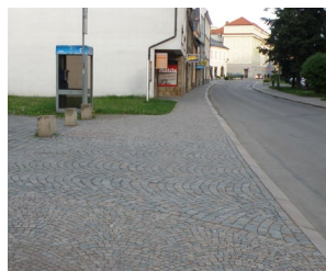
210 Vhodně provedený povrch chodníkového přejezdu ze stejného materiálu, jako je povrch chodníku, odlišen pouze velikostí (únosností) dlažebních kostek. Povrch chodníku je jasně vymezen odlišným materiálem oproti vozovce [ Litomyšl, Havlíčkova ]
