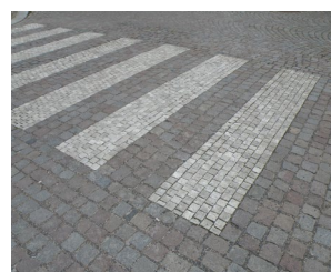
223 Vhodné materiálové řešení přechodu pro chodce, nahrazující vodorovné značení nátěrem [ Vysoké Mýto, náměstí Přemysla Otakara II. ]
