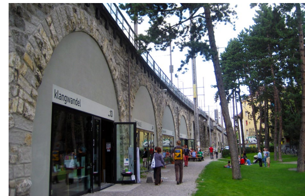
063 Viadukt v městském prostředí nevytváří takovou bariéru jako vedení železnice na valu. Je propustnější pro pohyb a oblouky viaduktu se dají využít i jako alternativní parter, čímž ožívají přilehlá prostranství [ Švýcarsko, Curych ]
