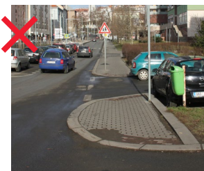
111 Nevhodné řešení křižovatky hlavní a vedlejší ulice s přerušenou kontinuitou chodníku [ Praha 10, Moskevská ]
