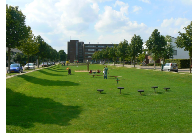
194 Integrované řešení – pobytová louka plní roli zasakovacího průlehu [ Nizozemí, Nijmegen ]
