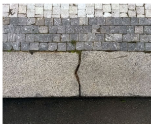
308 Kamenný žulový obrubník s kamenickým zámkem
