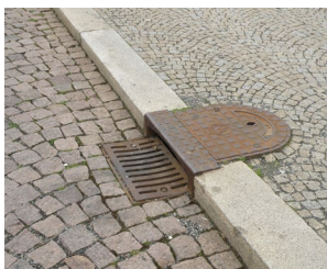
350 Vhodný příklad systému odvodnění ulice v obrubníku [ Kutná Hora, Palackého náměstí ]
