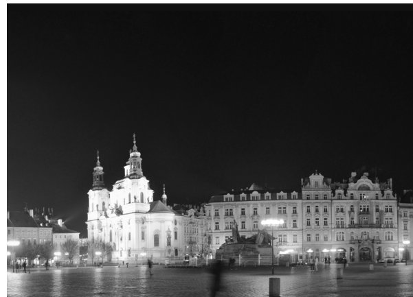
399 Charakter vyzařování svítidel zajišťuje osvětlení povrchu komunikace, fasád budov i celkové prosvětlení veřejného prostoru [ Praha 1, Staroměstské náměstí ]
