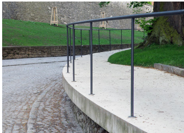
488 Vhodný příklad subtilního zábradlí jednotné barevnosti a umírněného designu [ Litomyšl, Jiráskova ]
