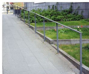
489 Vhodný příklad jednoduchého zábradlí užívaného v modernistickém městě [ Švédsko, Stockholm ]
