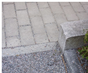
281 Maloformátová betonová dlažba
