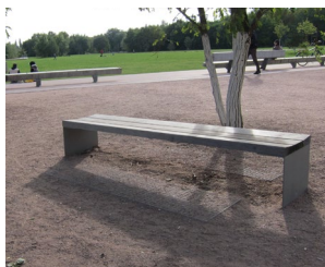
417 Ocelovým roštem lze zabránit aby se v místě nohou pod lavičkou neuhromadila voda [ Německo, Berlín ]
