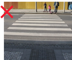
112 Bezbariérová úprava přechodu provedená jen z jedné strany naprosto pozbývá funkčnosti [ Praha 7, Letná ]
