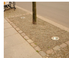
319 Ochrana výsadbového prostoru (rabátka) proti zhutnění štěrkovým mulčem [ Německo, Lipsko ]
