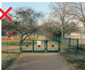
518 Neatraktivní oplocení dětského hřiště, které není součástí navazujícího prostoru a vytváří neadekvátní vymezení vůči okolnímu prostředí [ Praha 7, Letná ]
