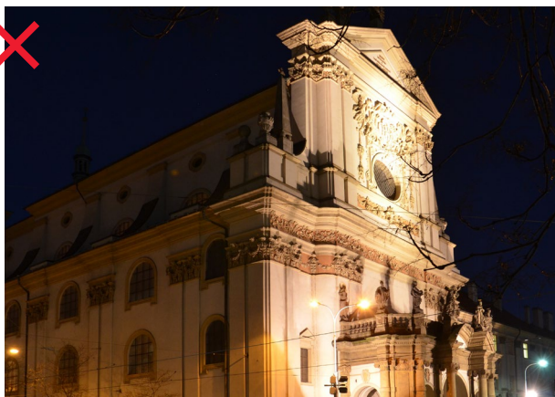
412 Plošné osvětlení s nevhodnou skladbou jasů a volbou osvětlených částí historického objektu [ Praha 2, Karlovo náměstí ]
