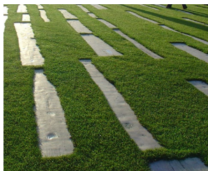
288 Velkoformátové desky pro pohyb po nezpevněném povrchu Použití: parky, trávníky, zpravidla mimo historické město
