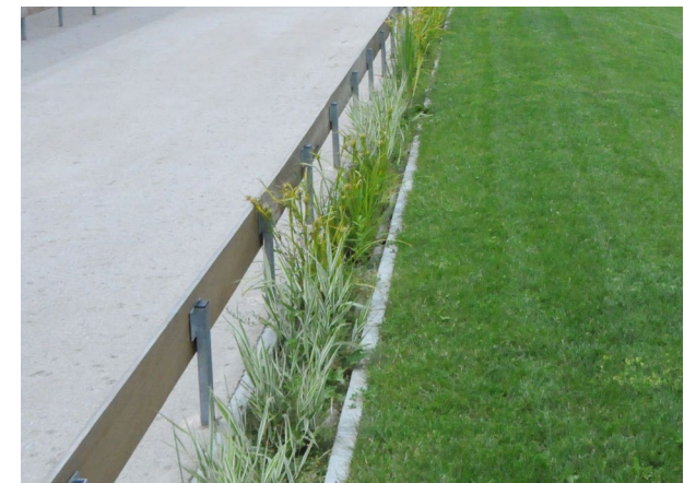
195 Filtrační zasakovací pás s podstatně vyšší propustností než navazující trávník [ Francie, Seine-Saint-Denis ]
