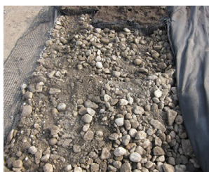
322 Strukturální zemina brání zhutnění a zajišťuje přístup kyslíku. Přitom umožňuje pokládání dlažby podobně jako na rostlý terén
