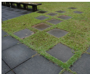
287 Velkoformátové desky pro pohyb po nezpevněném povrchu Použití: parky, trávníky zpravidla mimo historické město
