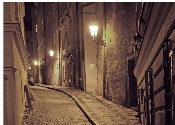
407 Příklad umístění svítidel veřejného osvětlení na fasády budov ve stísněných prostorech [ Praha 1, Jánkův vršek ]
