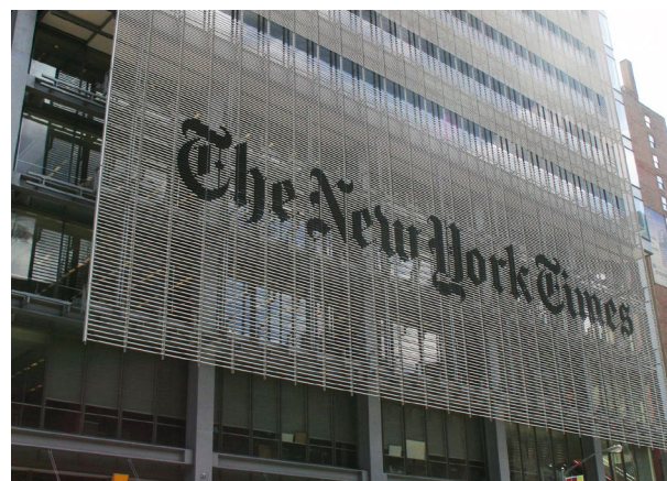
573 Reklama je součástí architektonického řešení objektu [ USA, New York ]
