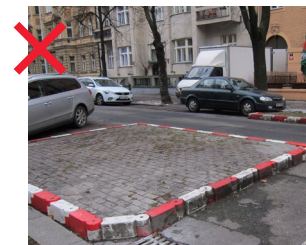
392 Plastové tvarovky slouží jako provizorní náhrada za obrubník. Dopravní vzhled však neodpovídá městskému prostředí a měl by být revidován. Tento prvek nesmí sloužit pro trvalé použití ve městě a je třeba vždy zvážit přiměřenost a míru použití [ Praha 7, Letná ]
