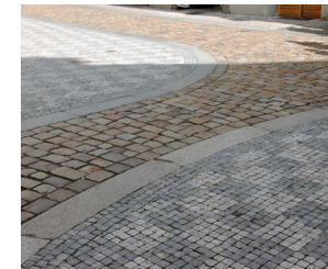
203 Scelení povrchové dlažby v jedné úrovni při zachování historické původní dlažby [ Praha 1 ]
