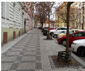
089 Chodník v klidné ulici, kde část pro průchod je vizuálně odlišena od části se stromořadím [ Praha 2, Rybalkova ]
