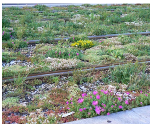
229 Extenzivní bezúdržbové zatravnění tramvajového pásu [ Itálie, Florencie ]
