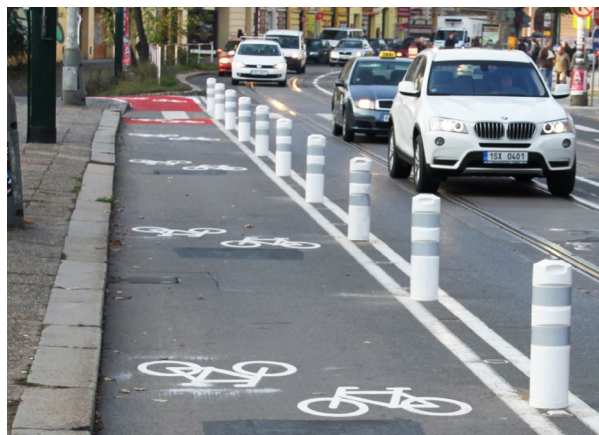
390 Tzv. balisety v bílém provedení jsou vhodnějším příkladem než často užívané zelené [ Praha 2, Albertov ]
