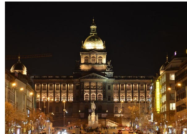
409 Vhodná kombinace plošného architekturního osvětlení a světelného zdůraznění vybraných částí budovy [ Praha 1, Václavské náměstí ]
