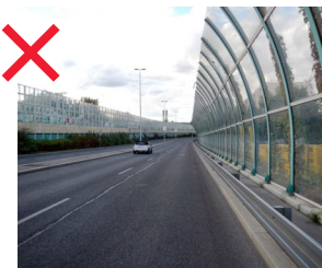
531 Protihlukové stěny užívané na městských komunikacích, které mají potenciál být městskou ulicí je zásadně nevhodné [ Praha 4, Modřanská ]
