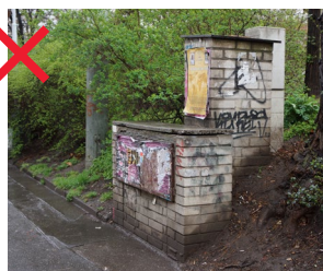
366 Nekoncepční a nezkoordinované umístování různorodých skříní technické a dopravní infrastruktury často i při snaze je sdružovat vede ke zcela neuspokojivým výsledkům [ Praha 2, Karlovo náměstí ]
