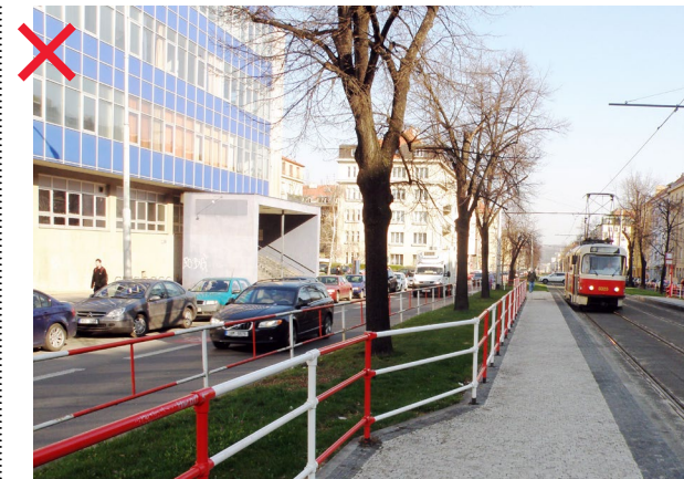
491 Příklad nadbytečného užití dvojitého zábradlí v místě, kde by vzhledem k jeho charakteru reálně nemuselo vůbec být [ Praha 6, Jugoslávských partyzánů ]
