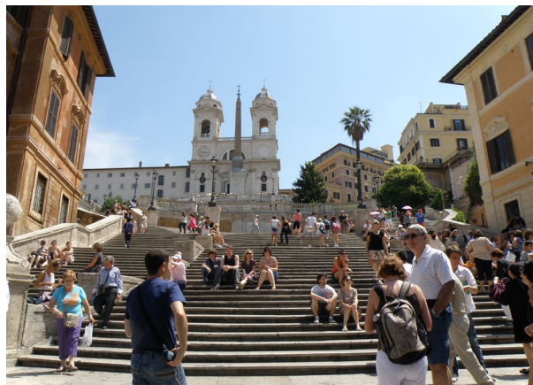
563 Kvalitní příklad schodiště, které zastává i roli městotvorného prvku ve veřejném prostoru [ Itálie, Řím ]
