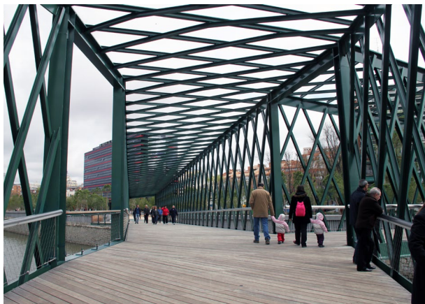
560 Architektonicky kvalitní lávka a současně městská promenáda s pobytovým charakterem a akcentací míst výhledů [ Španělsko, Madrid ]
