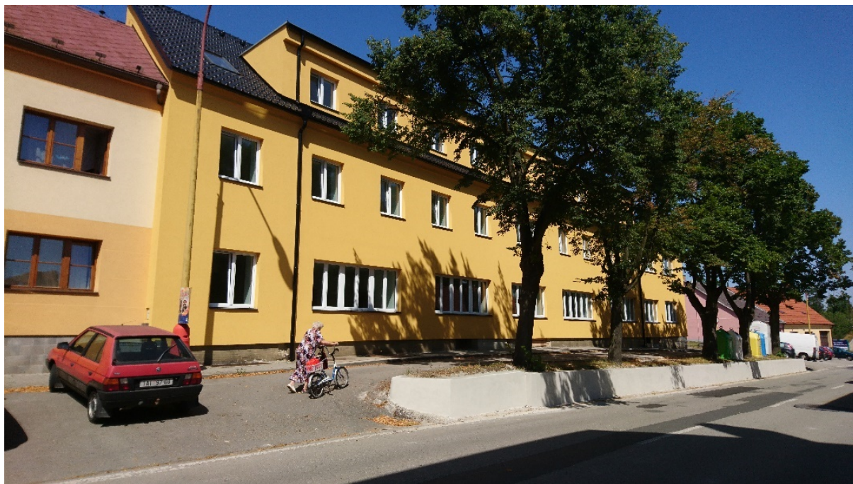
Obrázek 2.10: Sjezd z plochy u domu č. 172 v Masarykově ulici
