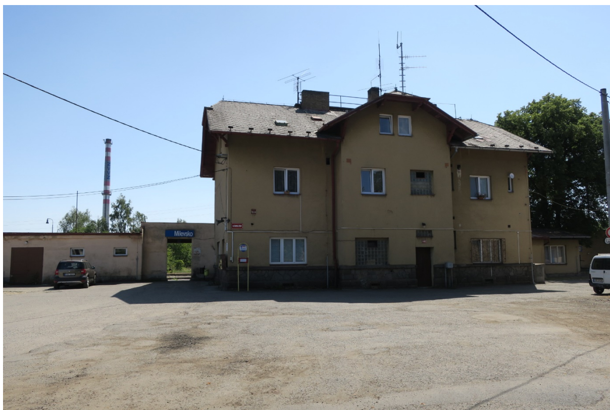
Obrázek 2.13: Nedostatečná infrastruktura před vlakovým nádražím
