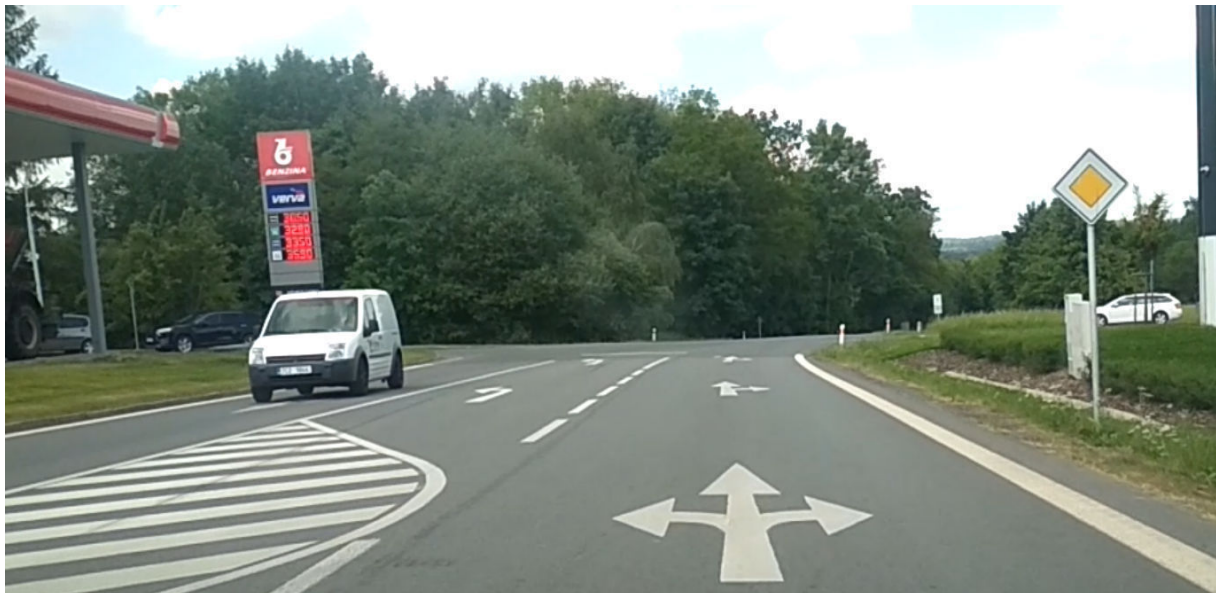
Obr. 11 Výhled řidiče z vozidla – příjezdový směr ke křižovatce od Písku
