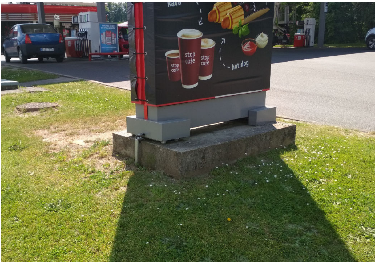
Obr. 20 Nebezpečné reklamní zařízení v bezpečnostní zóně silnice č. II/105
