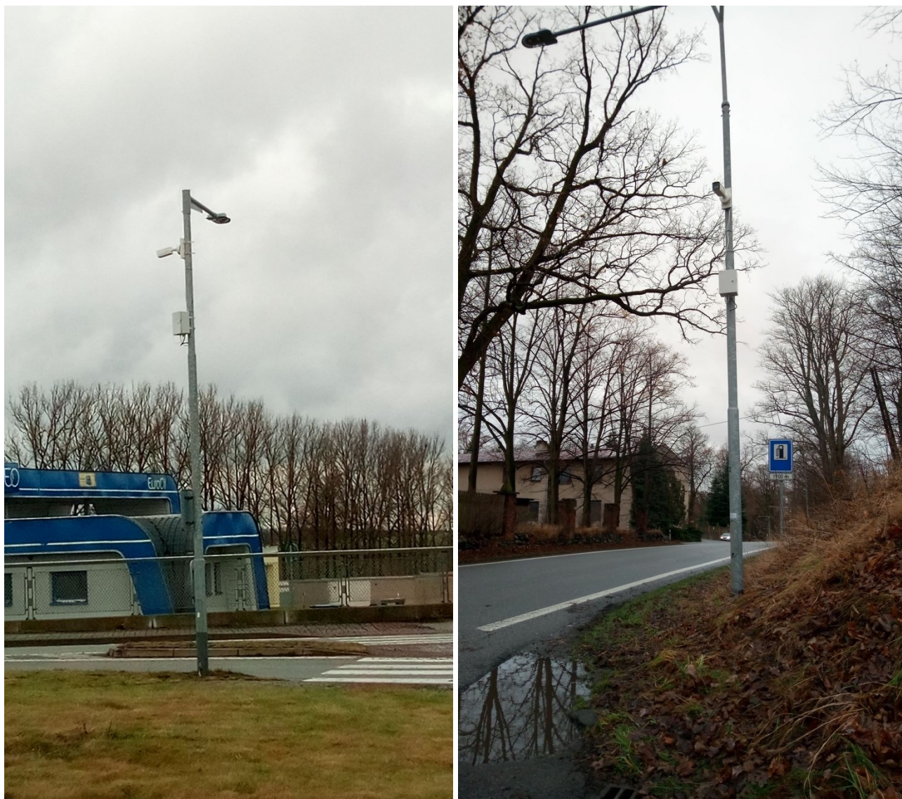
Obr. 8: Nainstalované kamera (2 a 1) v rámci projektu sčítání dopravy ve městě Chotěboř
