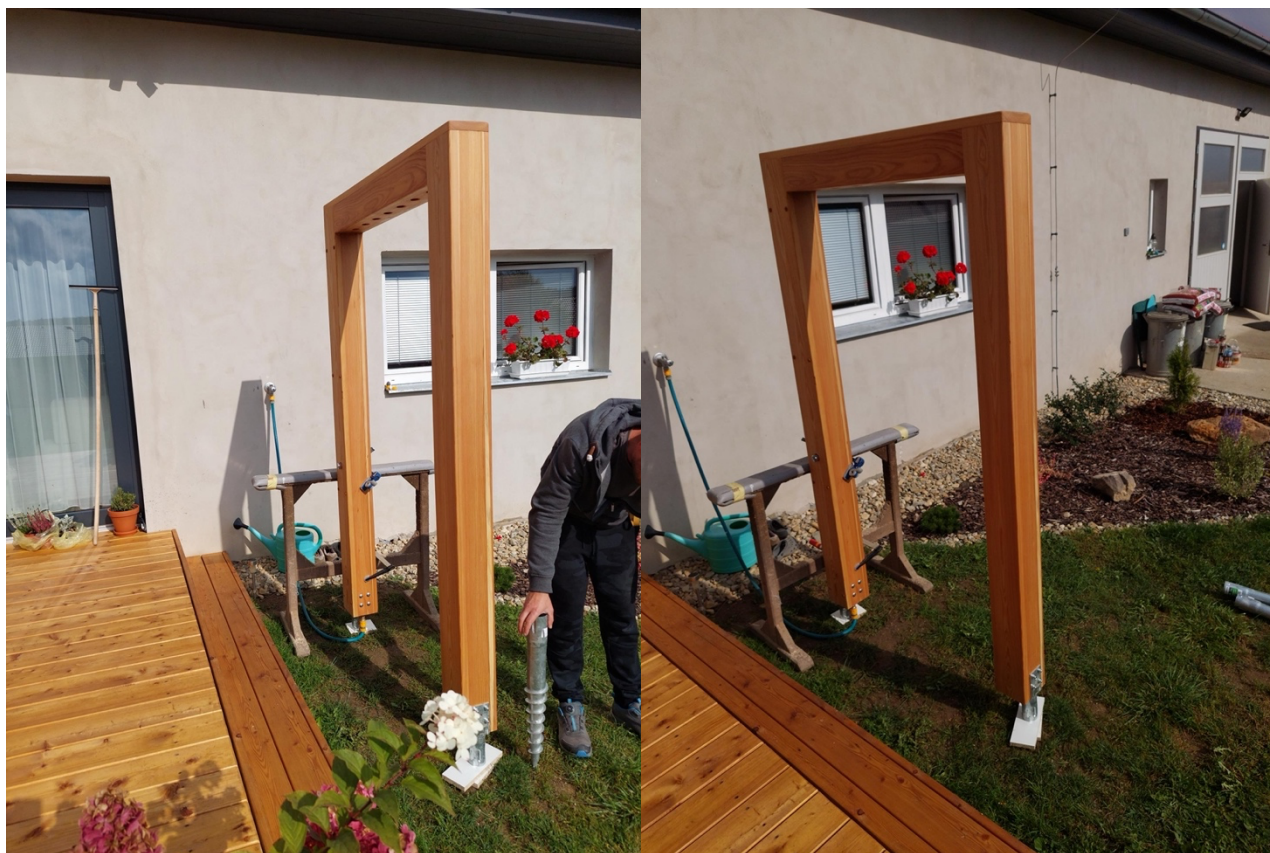
Obr. 12: Připravený modřínový rám s mlhovačem pro osazení ve městě Milevsko
