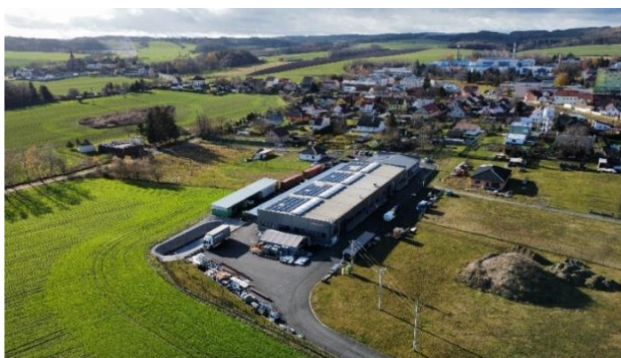
Obrázek 2 - Výrobní hala v Heřmanově Huti
