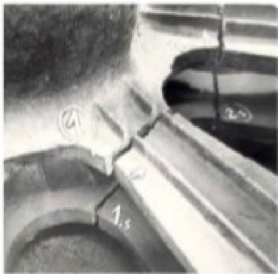
Trhlina za tepla
