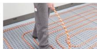
Potrubí upevněné na izolační desce suchým zipem
