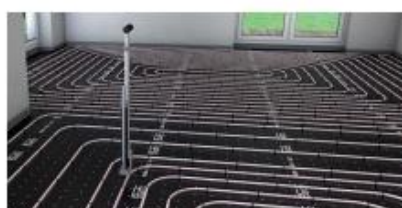
Potrubí upevněné na izolační desce pomocí háčků
