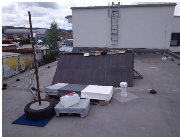
Obr. č.34 – Model na ploché střeše v areálu VSTE
