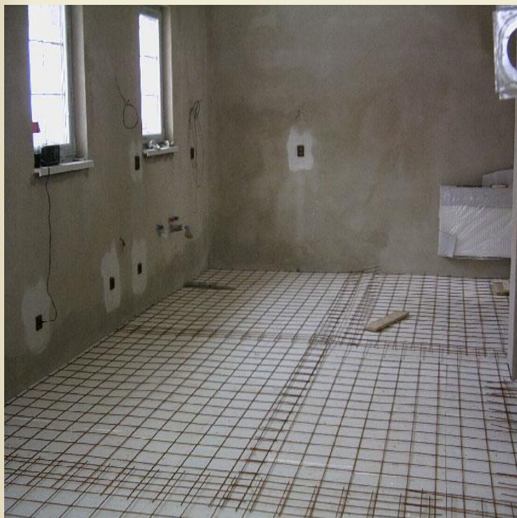
Pokládka tep. izolace
