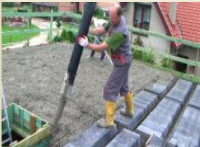
Betonáž stropu
