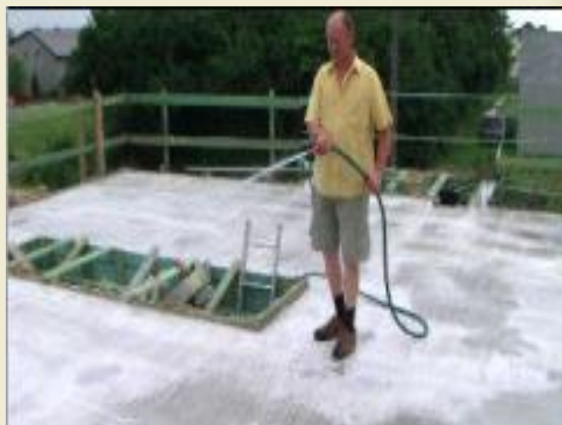
Ošetřování betonového stropu
